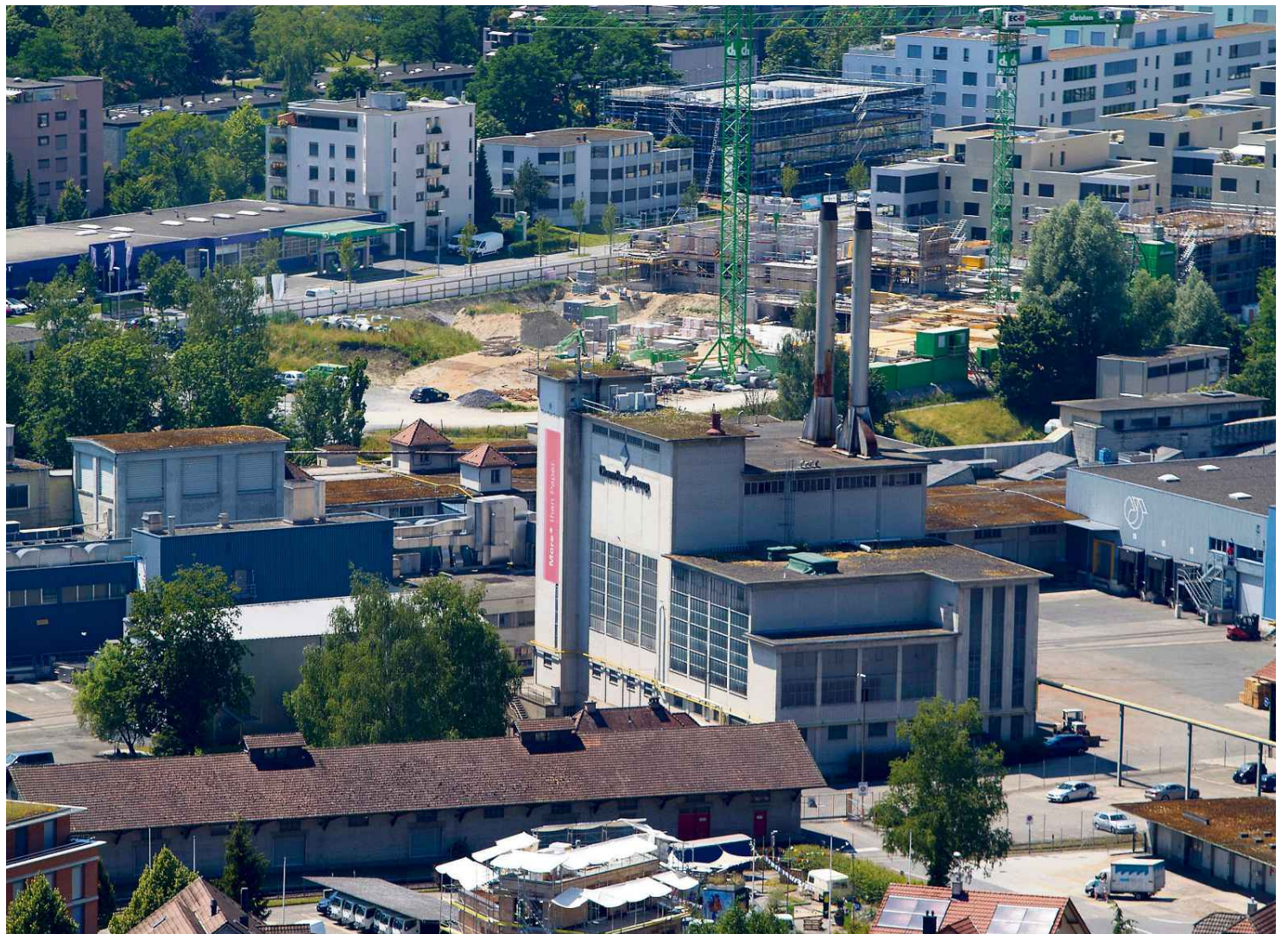
Auf dem 12 Hektar grossen Papierer-Areal soll ein neues Quartier entstehen. Bild Stefan Kaiser
