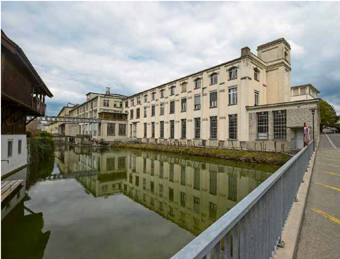
Dafür werden die alten Fabrikgebäude umgebaut und neue dazugebaut.
