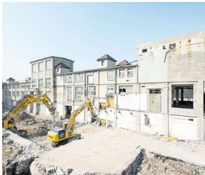
Die Abbrucharbeiten auf dem Papieri-Areal laufen auf Hochtouren.
