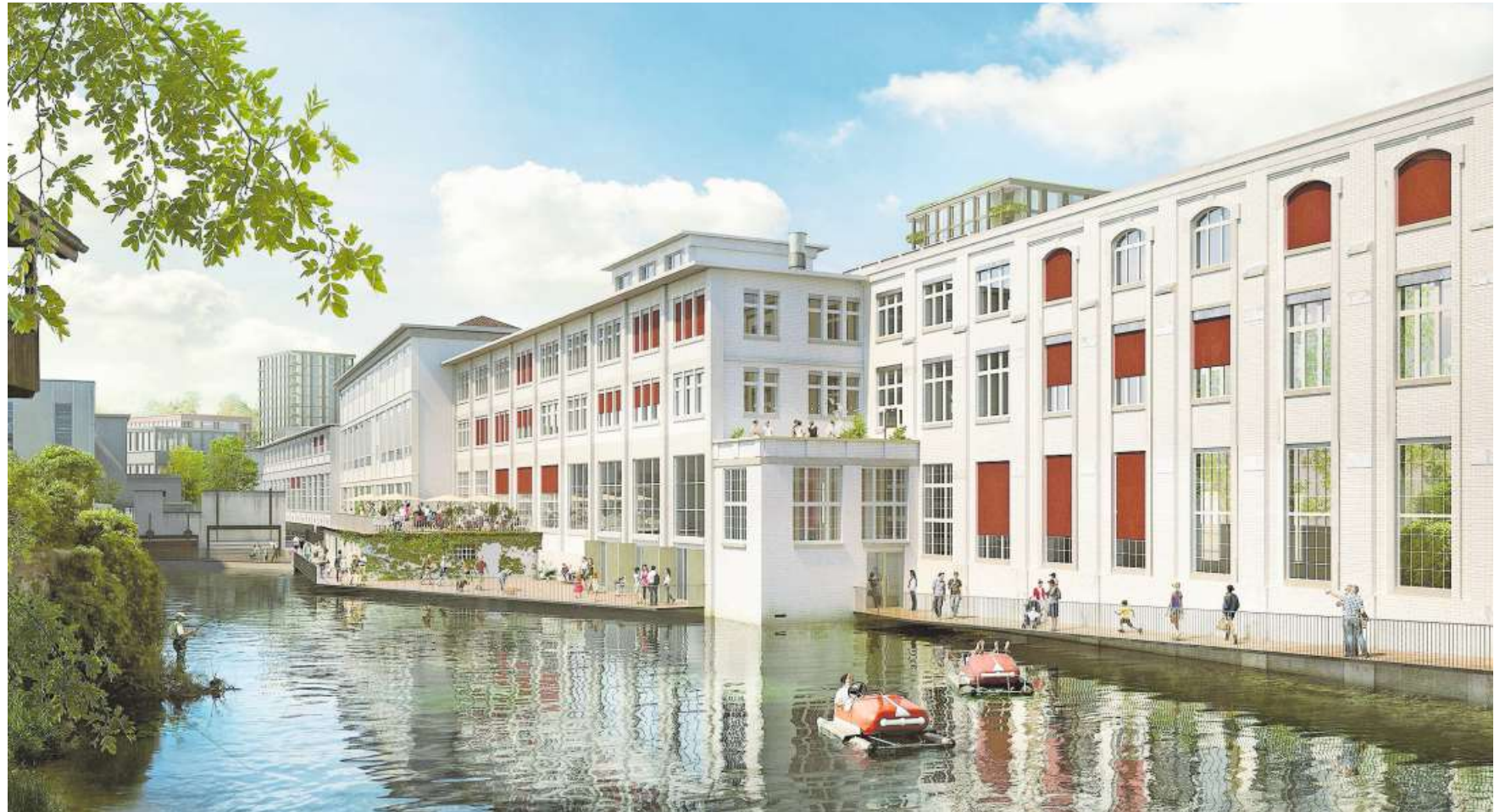
So dürften die denkmalgeschützten Fassaden nach dem Ausbau in der Papieri künftig aussehen.
