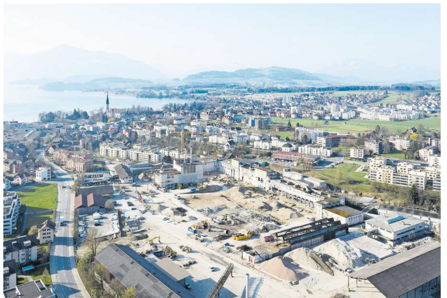
Aus der Vogelperspektive sind die Ausmasse der Baustelle des Papieri-Areals in Cham eindrücklich ersichtlich.
