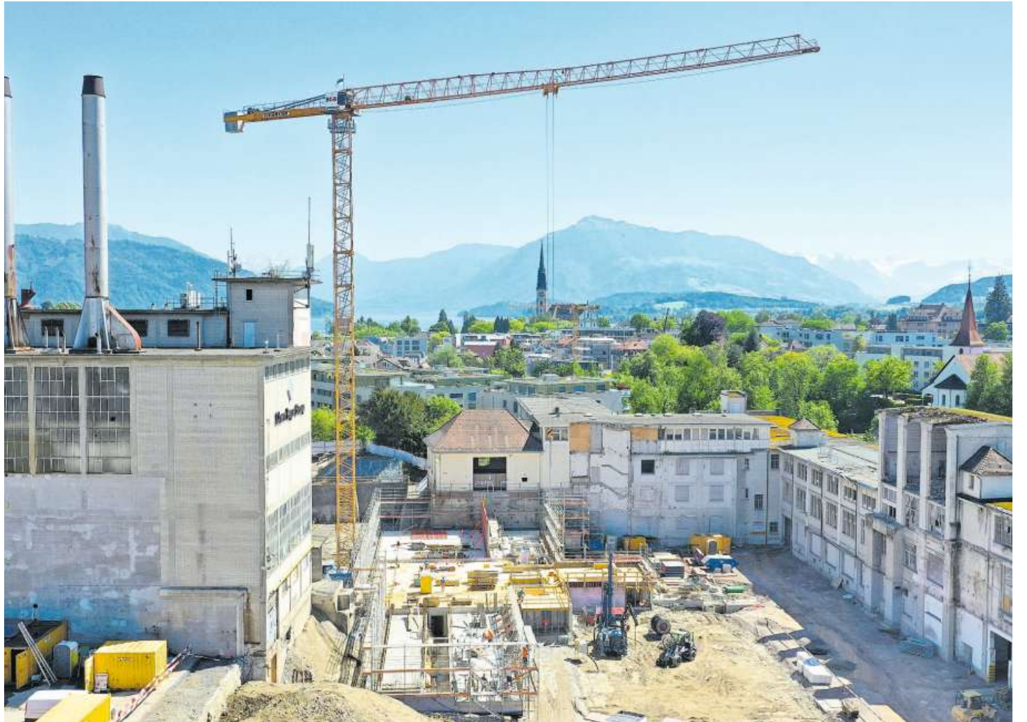
Die Aushubarbeiten für die Wohnprojekte laufen seit Februar.
