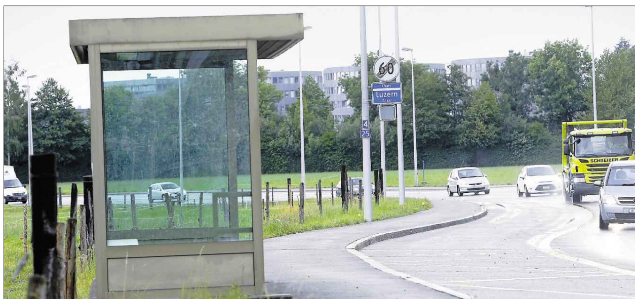
Auch das Bus-Wartehäuschen bei der Cholleremühle wird abgerissen.
