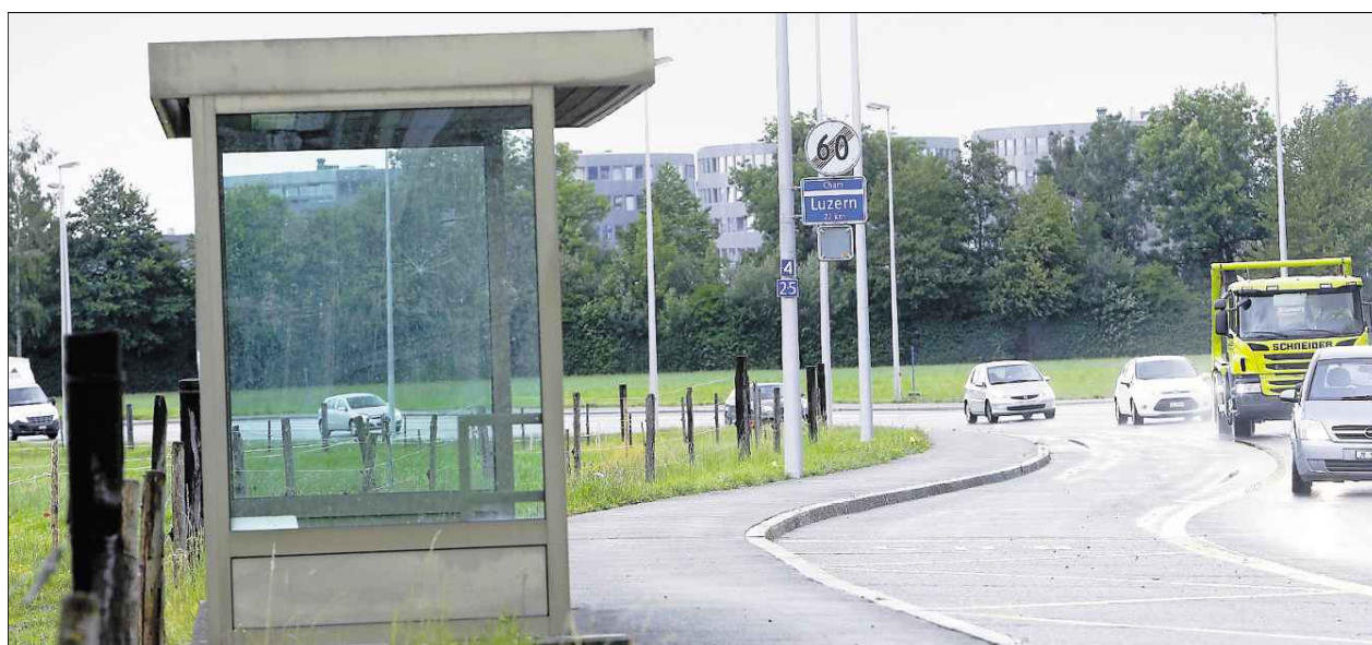
Auch das Bus-Wartehäuschen bei der Chollermlühle wird abgerissen.
